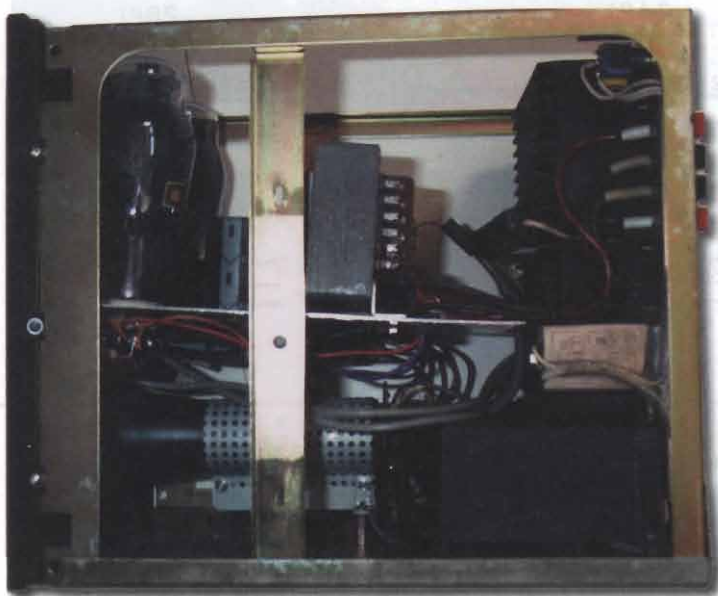
foto 4: Lato destro, CRT schermato con griglia forata in ferro
